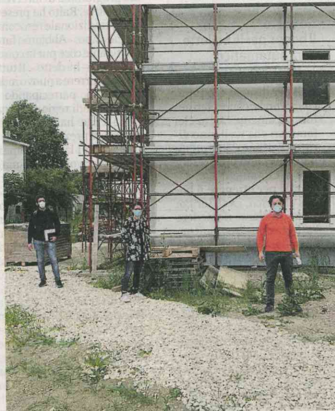
Il sopralluogo alle palazzine Acer in costruzione a Bondeno
