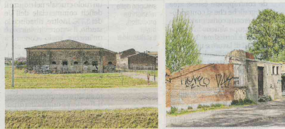
Qui sopra l'area edificabile in via Guido Carli, l'ex Felisatti e l'area di via Bentivoglio (foto Rubin)
