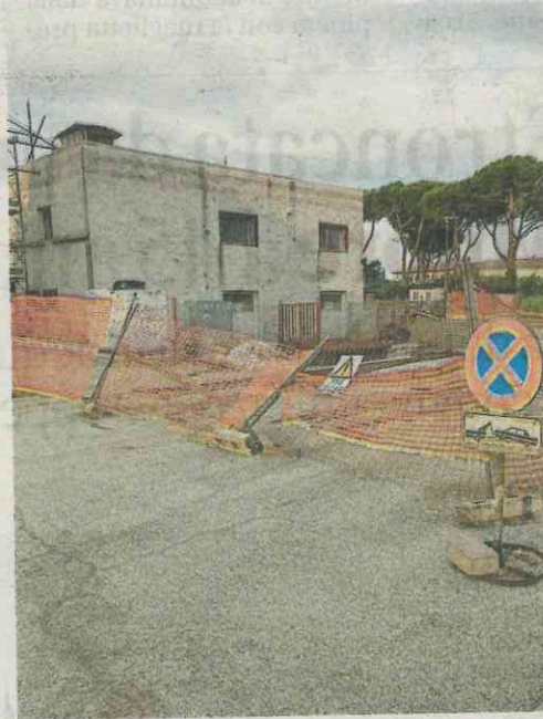
Il cantiere per il ripristino della piscina comunale
