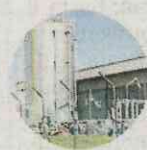
Geotermia a Cassana L'impianto rifornisce di calore la rete cittadina
